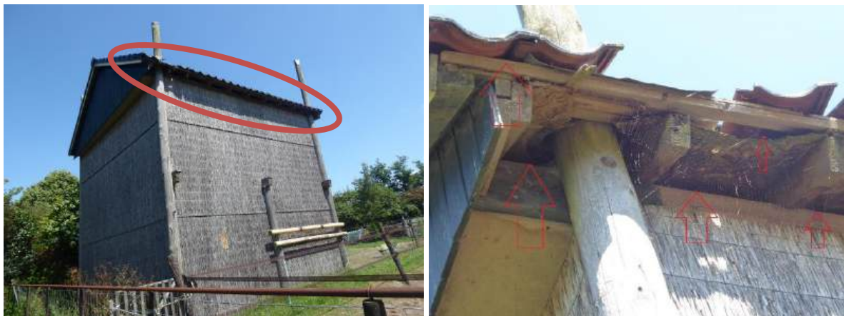
Figuur 2.2: Het houten schuurtje met meerdere ruimten onder het dak.
